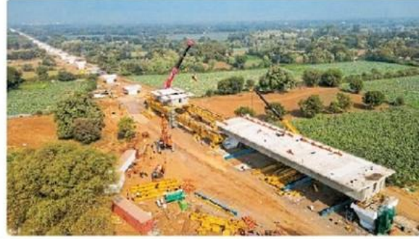
आणंद-नडियाद में निर्माणाधीन स्टेशन। बुलेट ट्रेन के लिए वडोदरा जिले में अंडरस्लंग मैथड़ से वायाडक्ट निर्माण।
